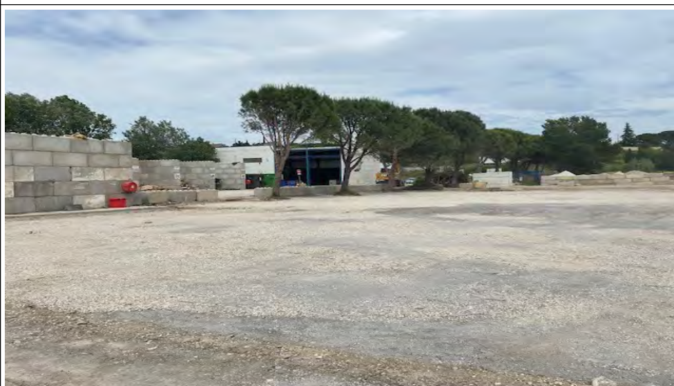
Photo n°6 – Absence de clôture entre les deux ICPE : Société Calcaires Régionaux et la société MAT'ILD
