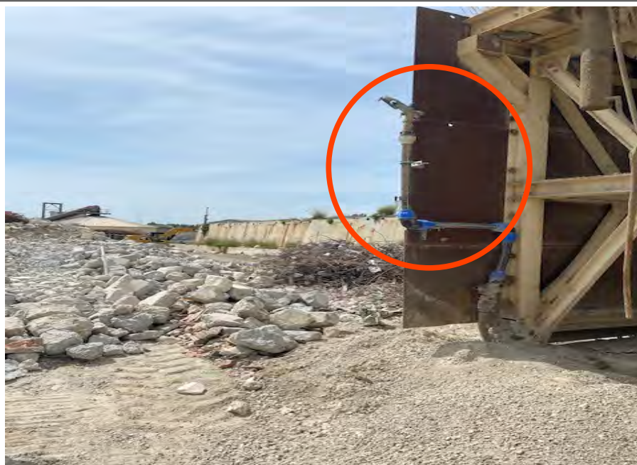
Photo n°8 – exemple d'aspenseurs situés à l'arrière du site
