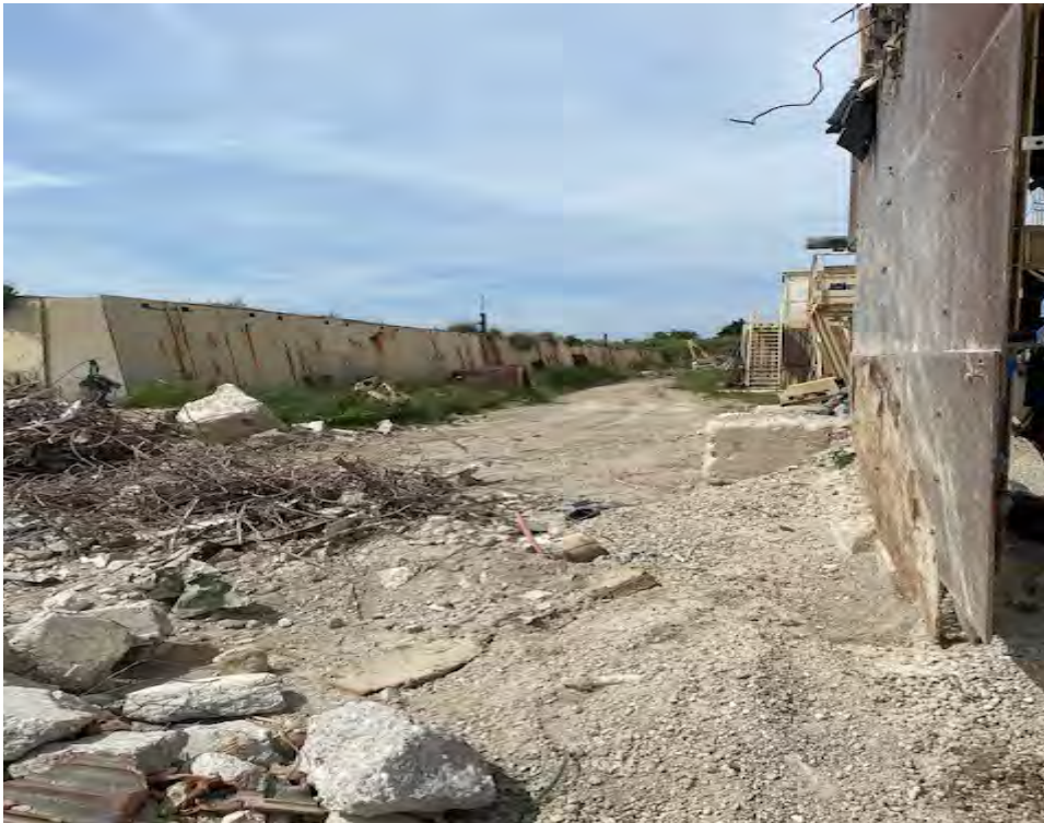
Photo n°9 – zone en cours de modification à l'arrière du site entre la société Calcaires Régionaux et une autre ICPE (NOVERGIE)
