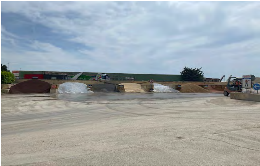
Photos n°1 – stocks de matériaux ( déco) situés à l'entrée du site
