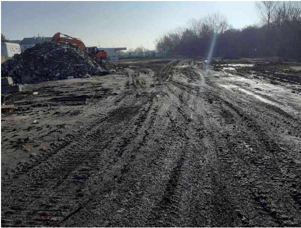
Illustration 1 : zone sud évacuée des stockages de mâchefers et future plateforme de l'UTE
