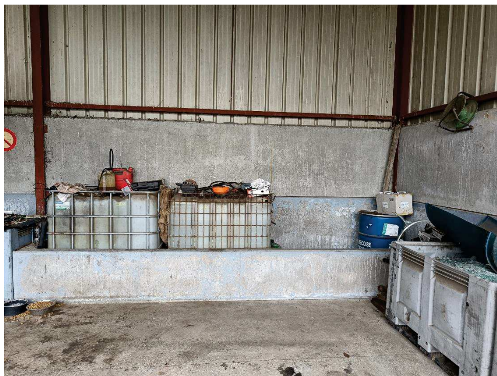
Figure 2 : Conteneurs de 1 000 litres sur rétention
