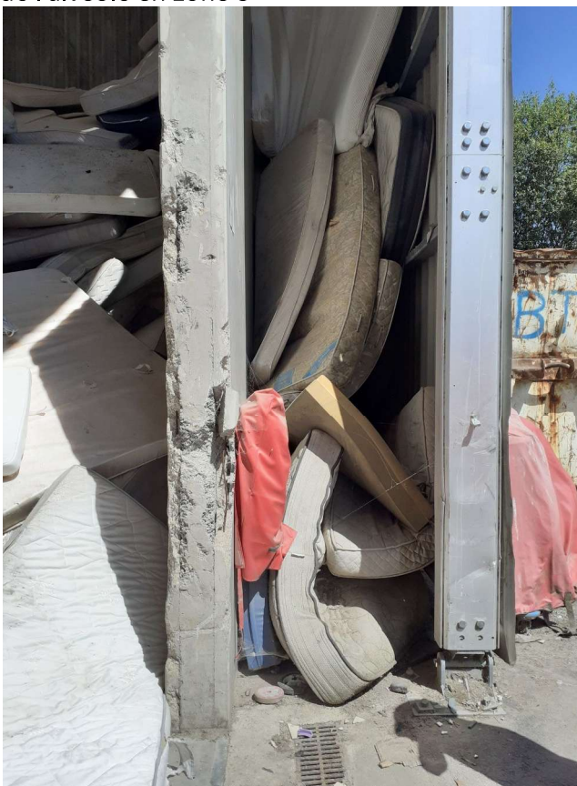
Déchets entre la paroi de l'alvéole et le bardagellot de bennes ne respectant pas les 10m de du bâtiment, entravant l'accès à l'extincteur
