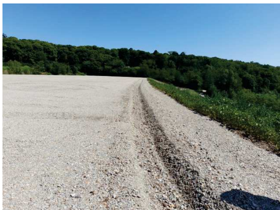
Vue haut plateforme rigole eaux pluviales
