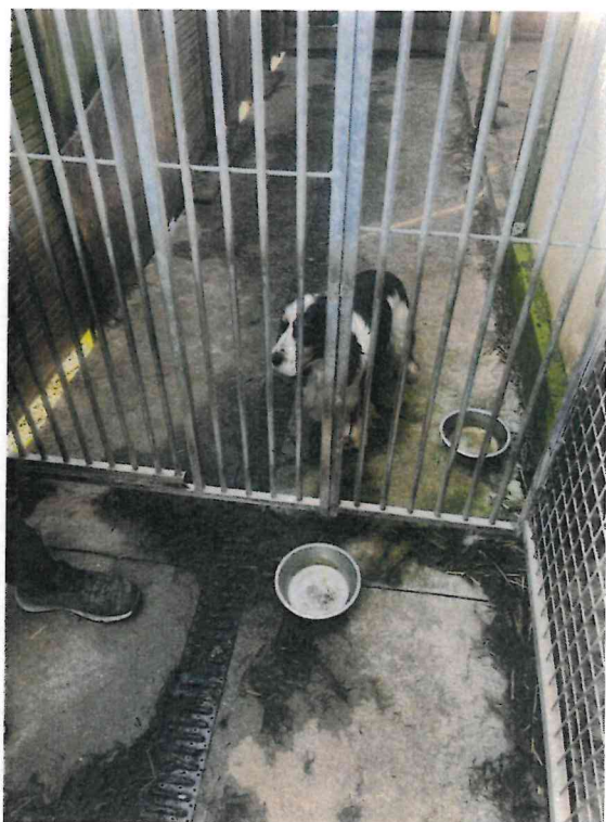
Murs non imperméables
