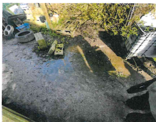
Extérieur du local technique
