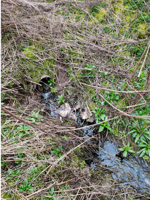
Canalisation de sortie lixiviats traités dans un petit fossé
