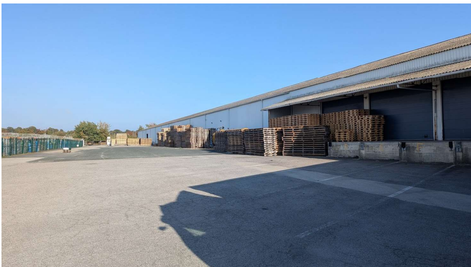
Vue du stockage le long du bâtiment
