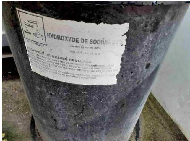
Étiquetage de la cuve de stockage de soude à l'extérieur du local traitement de surface
