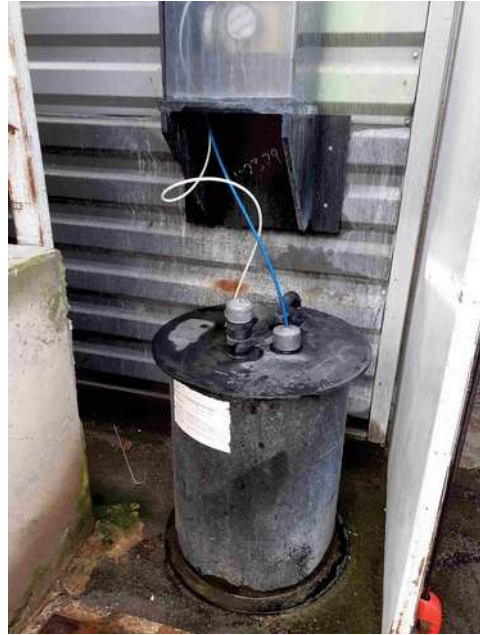
Cuve de stockage de soude à l'extérieur du local traitement de surface
