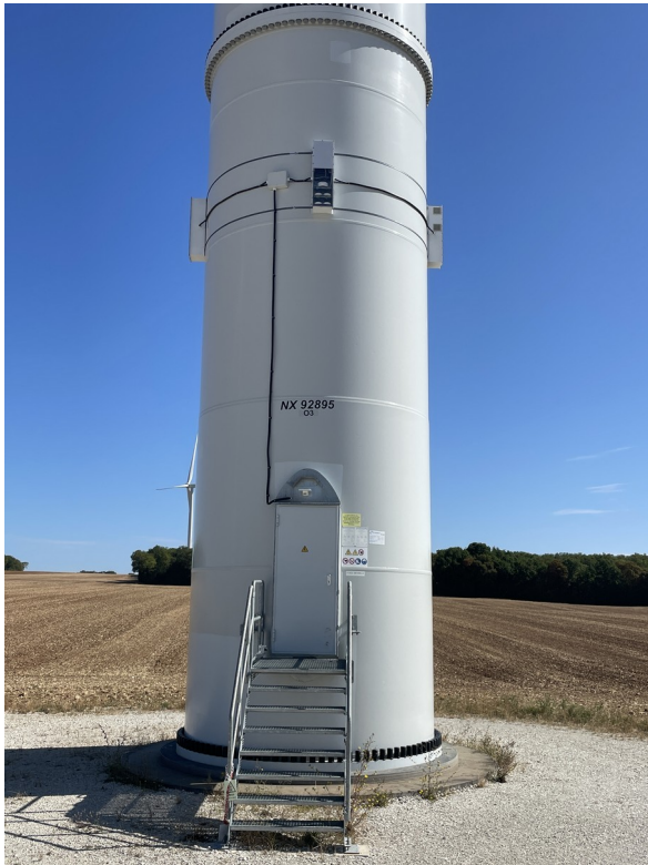
Figure 1 : Système de détection installé
