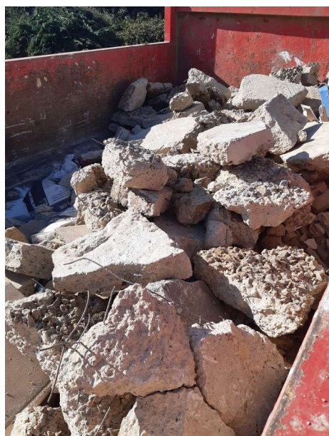
Benne plâtre contenant de nombreux gravats
