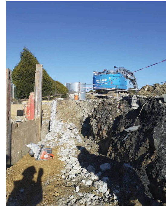
Fosse – partie en cours d'excavation – blindage
