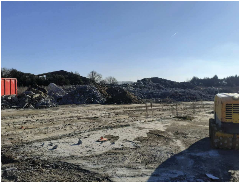
Matériaux issus de la démolition en cours de concassage
