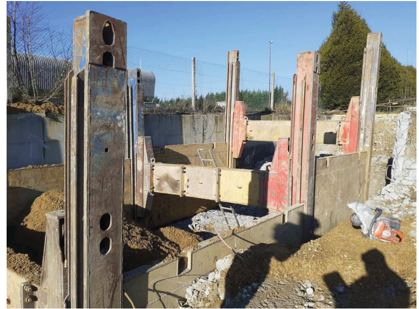
Fosse – partie en cours d'excavation – blindage
