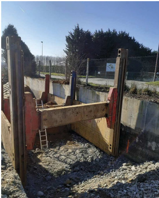
Fosse – partie en cours d'excavation – blindage
