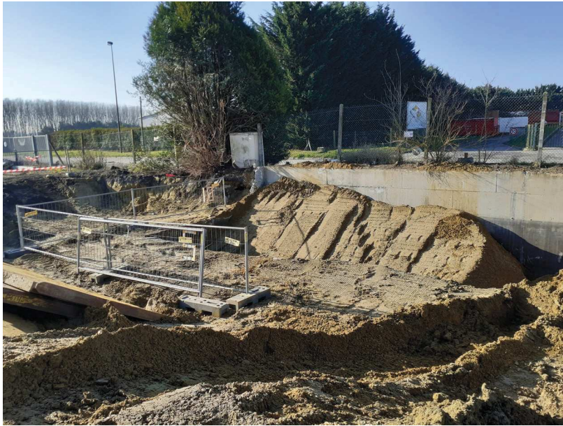
Fosse – partie excavée
