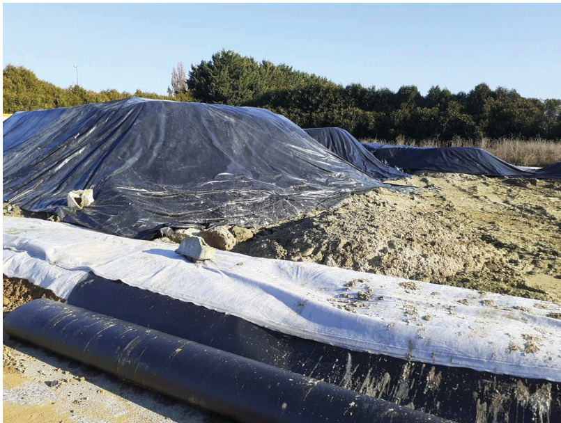
Stockage des matériaux excavés sur bâche polyane et géotextile
