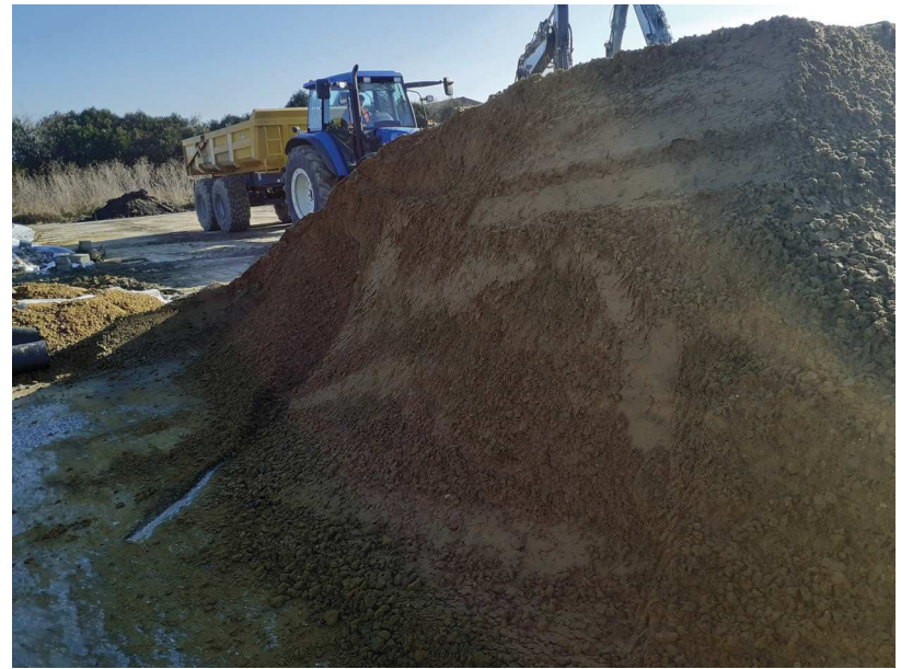
Matériaux d'apport pour aménager les accès aux engins au niveau de l'excavation
