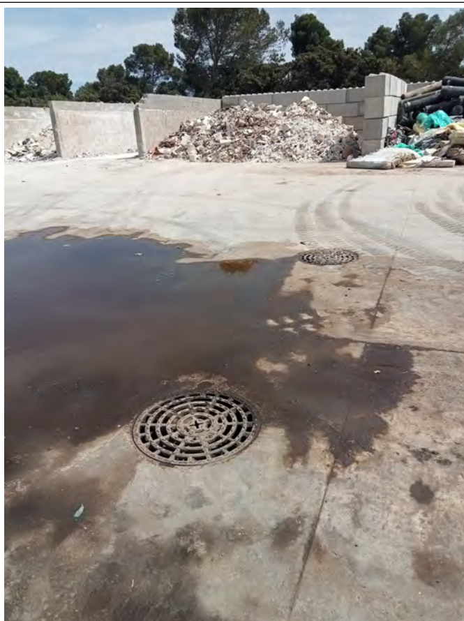
Regards de collecte au centre de la zone en pointe de diamant
