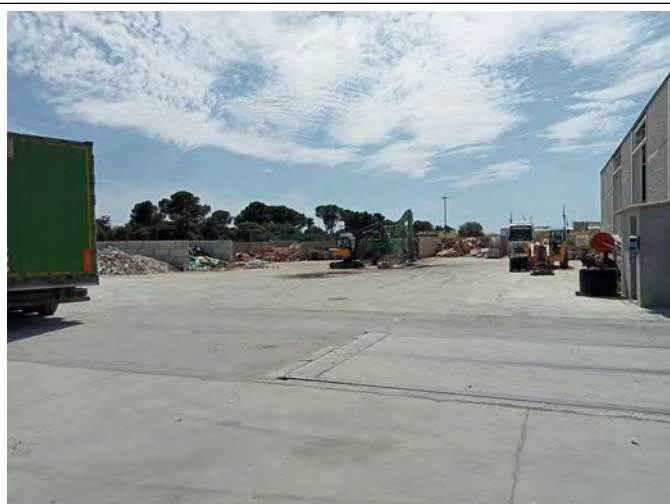
Travaux de mise en étanchéité de la plateforme achevés
