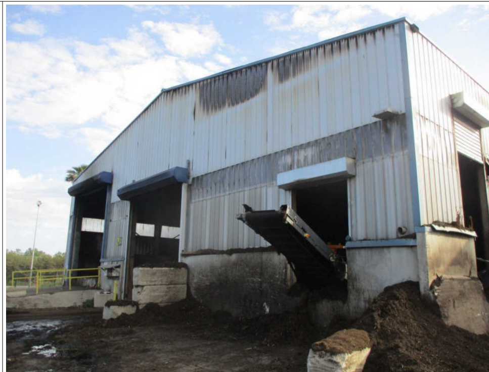
Face Nord-Nord-Ouest du bâtiment de préparation du mélange déchets verts - boues
