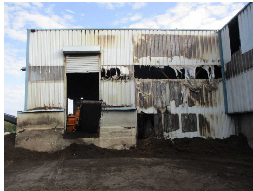
Face Ouest-Sud-Ouest du bâtiment de préparation du mélange déchets verts - boues
