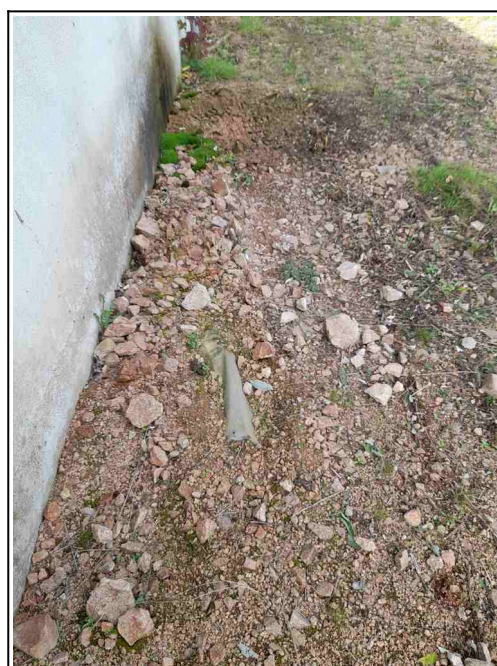
Photos n°3 – 4 : Géotextile apparent
