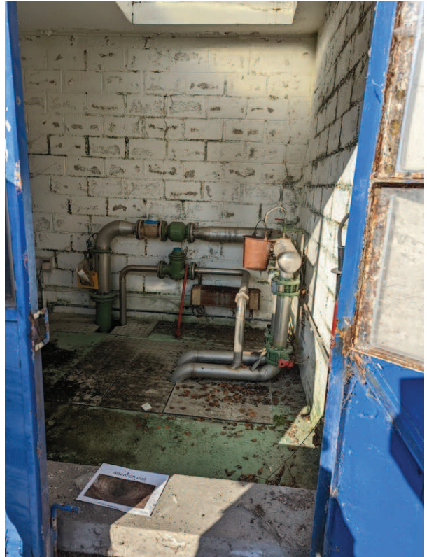
Forages présents sur le site Les forages sont dans des locaux fermés à clé, les vannes sont coupées.
