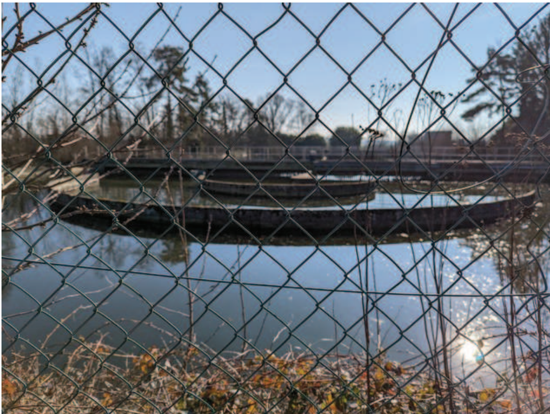
Bassin de la station d'épuration
