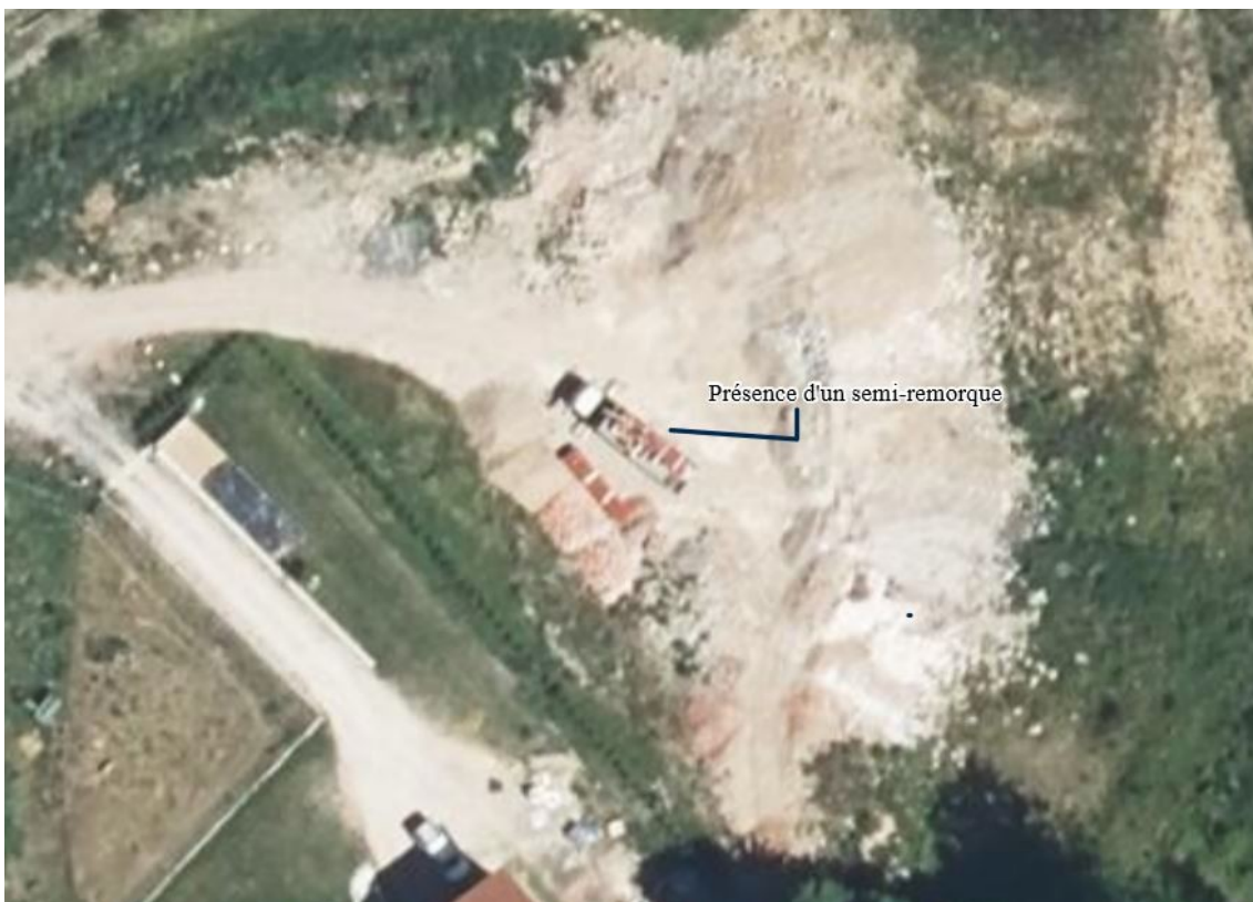
Figure 3: Présence d'une semi-remorque, parcelle non clôturée : accès libre au site
