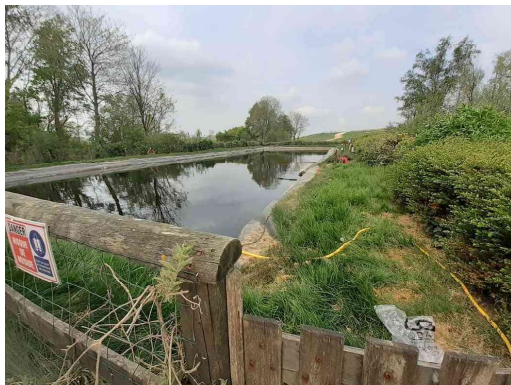
Illustration 5 : bassin tampon de réception des lixiviats (BL10)
