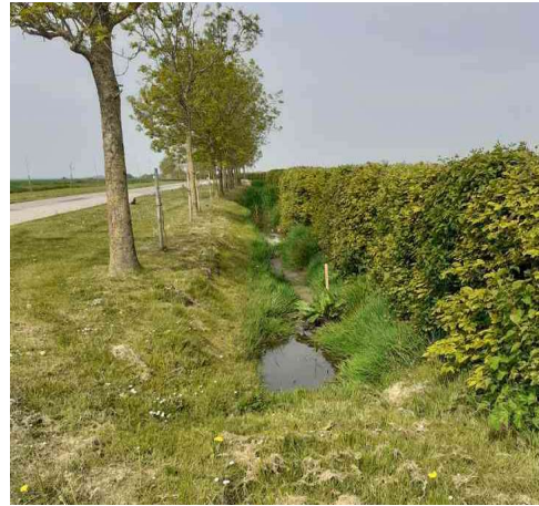
Illustration 2 : fossé de réception du rejet n°1 des eaux pluviales vers le milieu naturel
