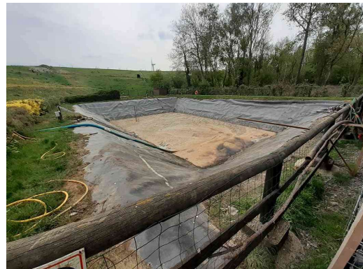
Illustration 6 : bassin tampon de réception des lixiviats (BL9)
