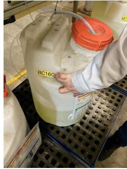
Partie des stockages sur rétention dans le local TAR compressor room
