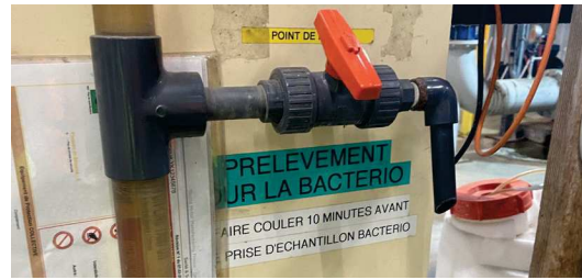
Point de prélèvement de la TAR Plastic room Point de prélèvement de la TAR Compressor room
