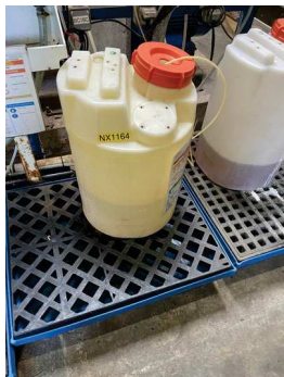
Stockages sur rétention dans le local TAR plastic room
