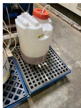
Stockages sur rétention dans le local TAR plastic room
