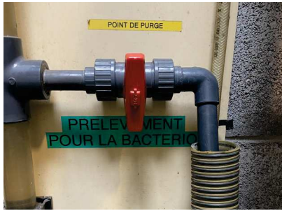
Point de prélèvement de la TAR Plastic room Point de prélèvement de la TAR Compressor room
