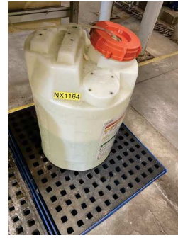
Partie des stockages sur rétention dans le local TAR compressor room
