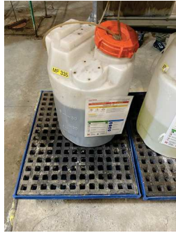
Partie des stockages sur rétention dans le local TAR compressor room
