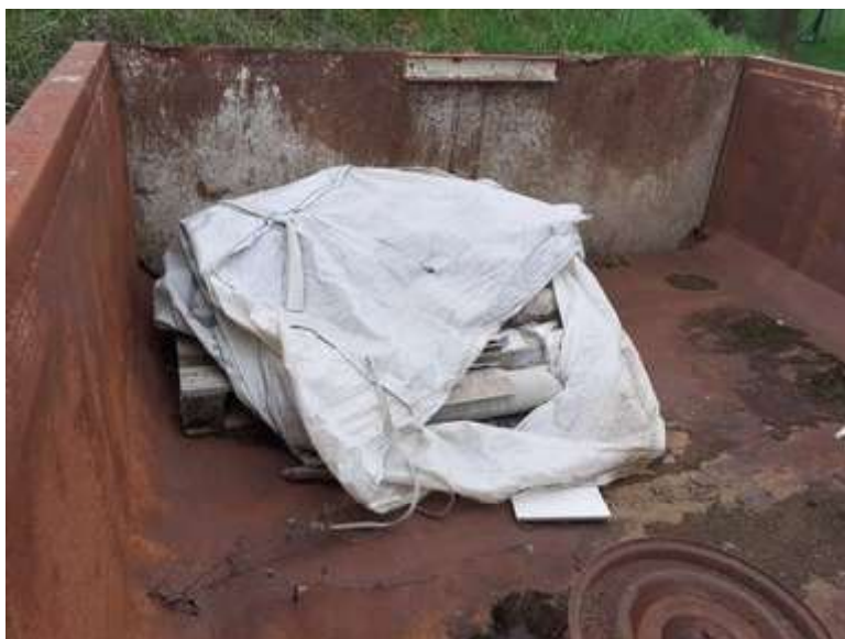
Big bags contenant des déchets d'amiante liés à des matériaux de construction
