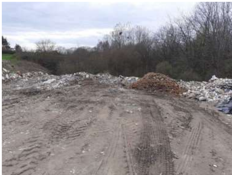
Zone de déchargement et de contrôle non matérialisée des apports de déchets inertes
