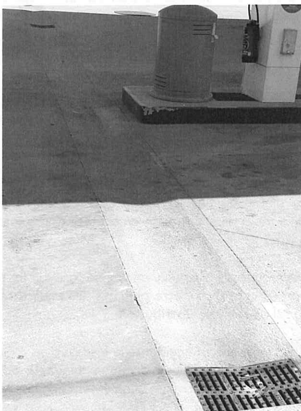
Figure 1: Aperçu de l'avaloir, sur l'aire de distribution du côté du second îlot (côté route), dénommé « EH2 » par TOTAL (photo inspection)
