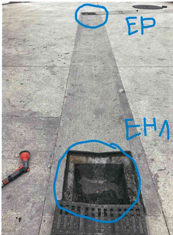
Figure 2: Aperçu de l'avaloir, sur l'aire de distribution du côté du premier îlot (côté route), dénommé « EH1 » par TOTAL (photo communiquée par TOTAL)
