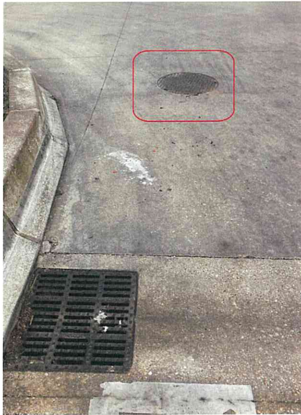
Figure 3: Aperçu du tampon en sortie du dispositif décanteur-séparateur sur l'aire de distribution du côté du premier îlot (côté route), remplaçant l'avaloir en sortie sur le plan, ainsi que de l'avaloir dénommé « EH2 » par TOTAL (photo communiquée par TOTAL)
