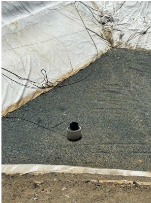
Puit de pompage des lixiviats du casier 4.2
