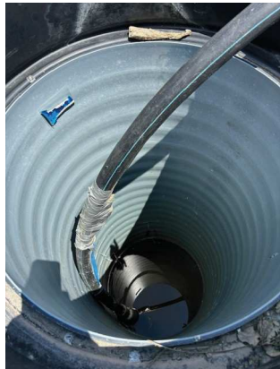
Puit de pompage des lixiviats du casier 4.2
