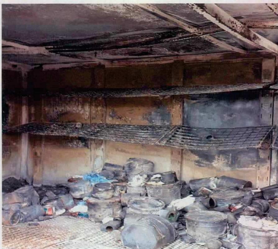
Intérieur du local de stockage des déchets dangereux
