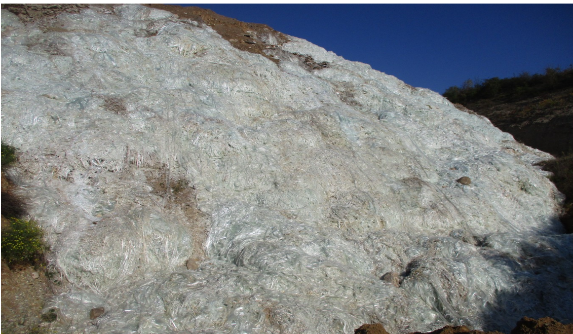
Figure 2: Déchets de fibres de verre dans la pente du massif de déchets
