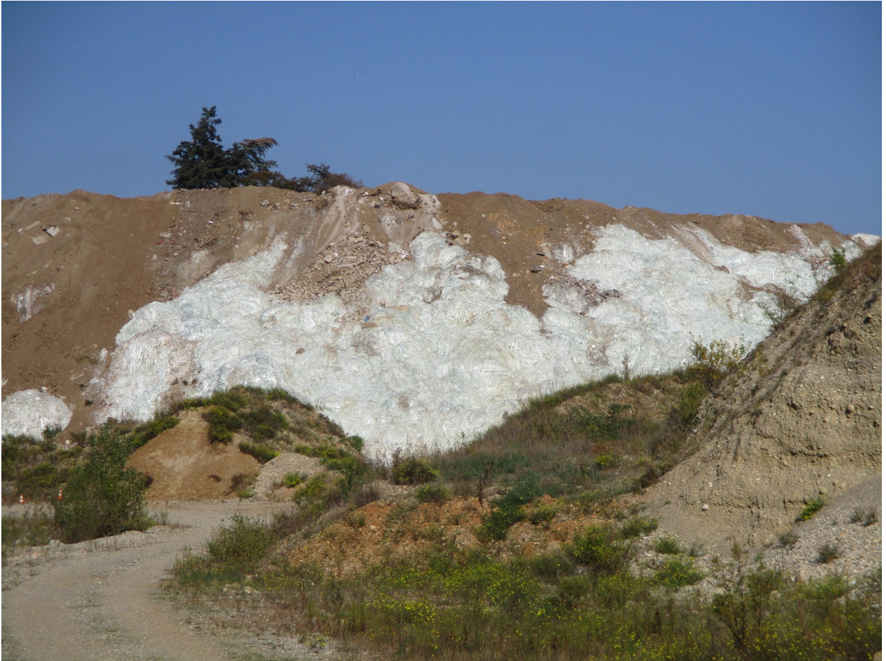
Figure 1: Déchets de fibres de verre dans la pente du massif de déchets de l'ISDI
