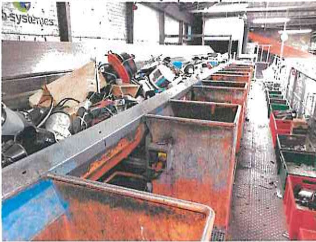
Photo 13 : postes de pré-tri manuel dit de phase 1 sur le convoyeur d'amenée au QZ
