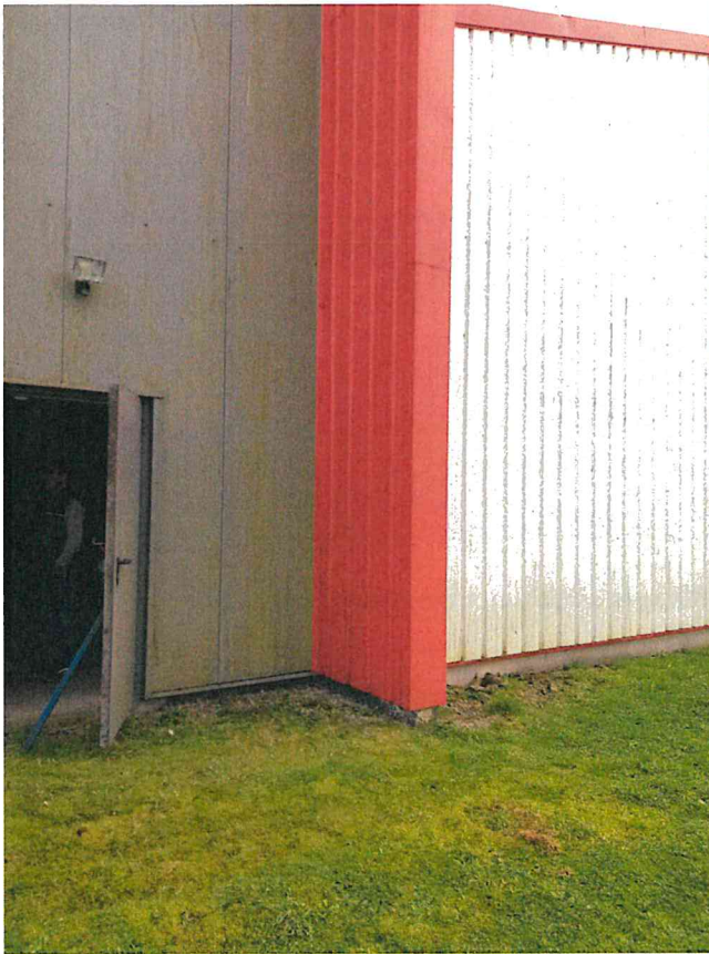
Photos 5 et 6 : mur coupe-feu dépassant en façade et en toiture
