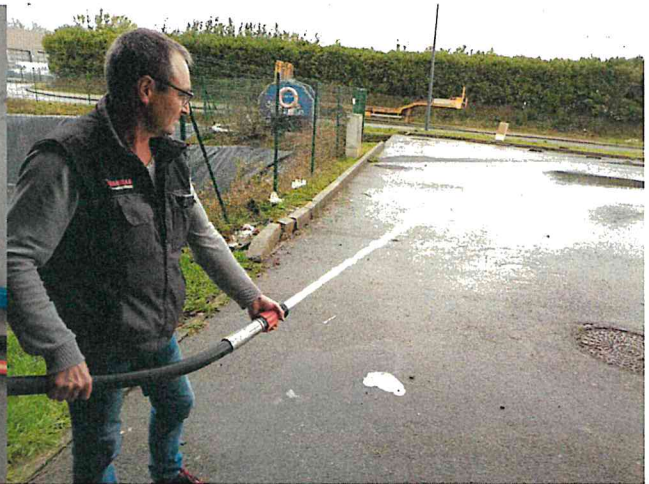
Photo 11 : étiquette de contrôle du RIA en juillet 2023 Photo 12 : test concluant d'un RIA choisi au hasard
