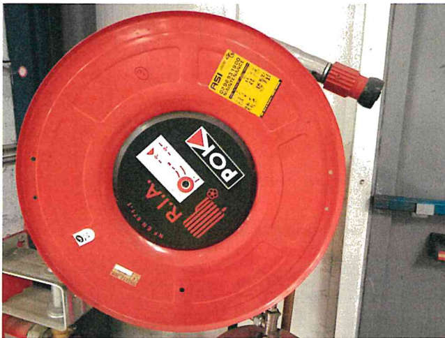
Photo 11 : étiquette de contrôle du RIA en juillet 2023 Photo 12 : test concluant d'un RIA choisi au hasard
