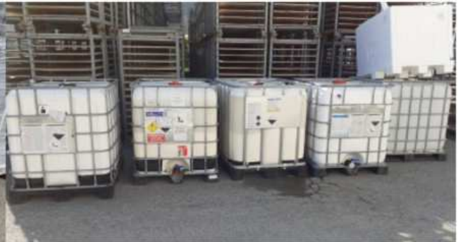
Stockage de produits chimiques sans rétention, présentant notamment des fuites
