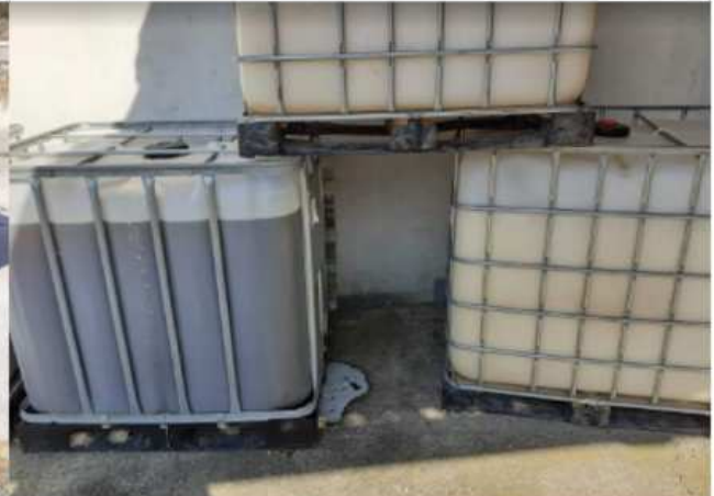
Stockage de produits chimiques sans rétention
