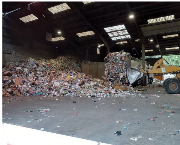
Bâtiment de stockage des déchets recyclables
