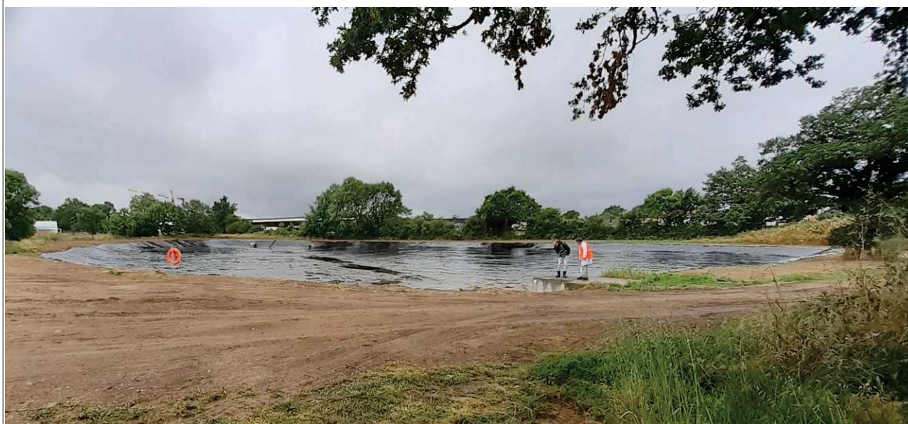
Nouveau bassin de confinement
