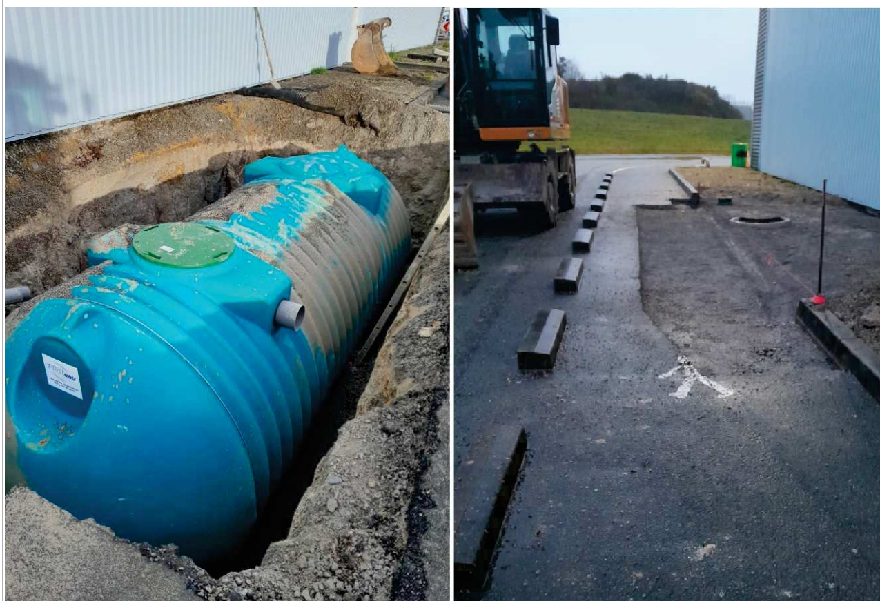
Travaux de remplacement de la cuve de rétention n° 2 (photos SPBI, janvier 2025)
