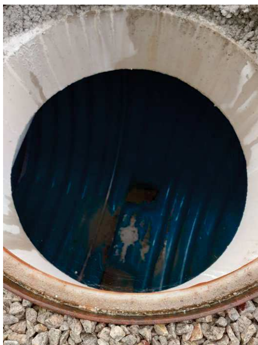
Cuve de rétention n° 2
