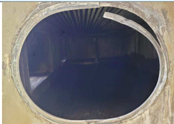
Joint trappe de visite en mauvais état - A remplacer
