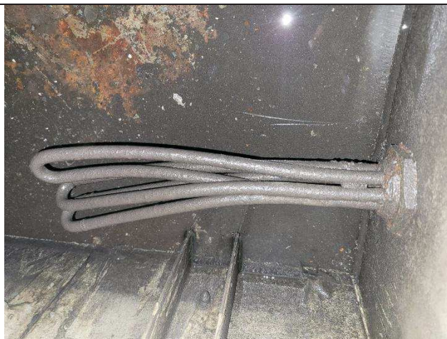
Résistances électriques en très mauvais état - A remplacer
