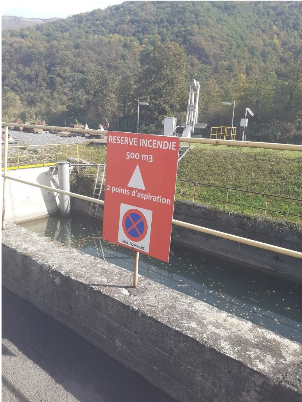
Photo n°3 bassin d'eau incendie de 500m 3
