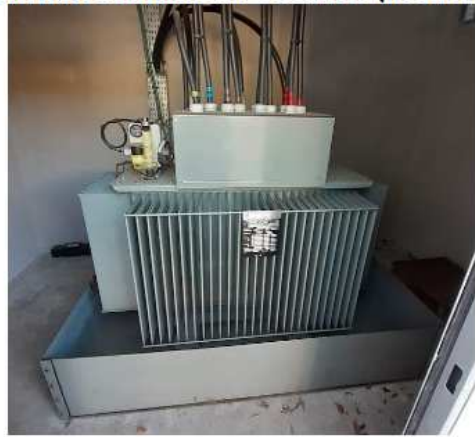
Transformateur mise en sécurité (local fermé)
