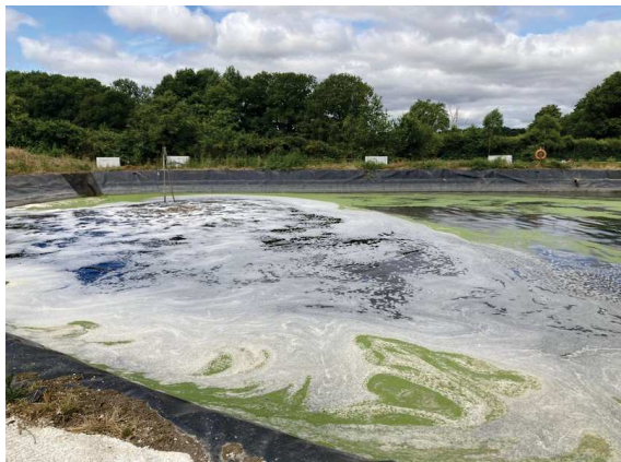
Lagune de récupération des eaux de ruissellement de la plateforme de compostage
