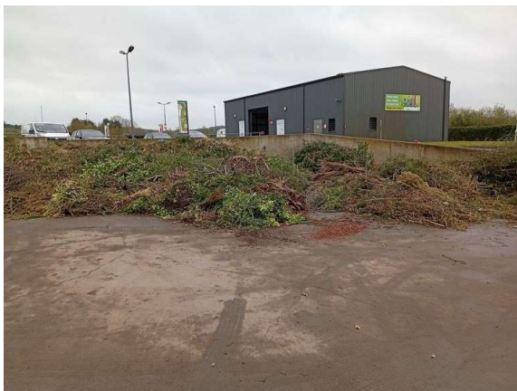
Stockage des déchets verts ceinturé par un mur béton d'une hauteur d'environ 2 mètres
