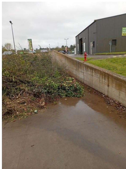
Localisation du poteau incendie mobilisable en cas de sinistre et potentiellement inutilisable en cas de propagation d'un incendie dans le stock de déchets verts
