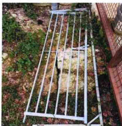
Plaques accès fosse
