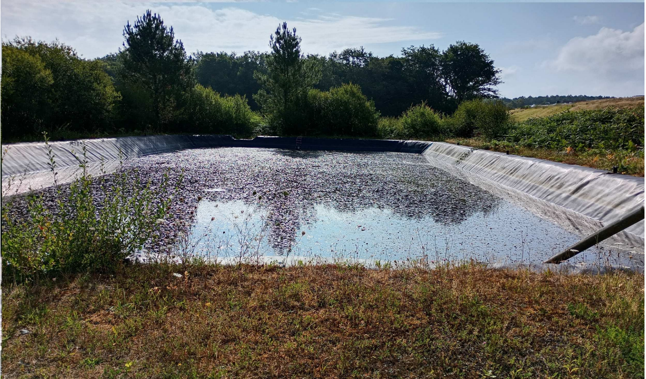
Bassin de stockage Nord
