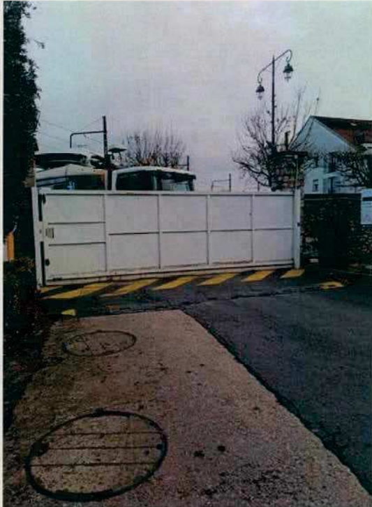
Entrée du site
