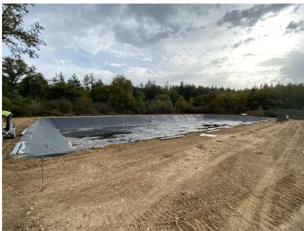
Bassin de récupération des eaux de ruissellement collectés dans le casier D1
