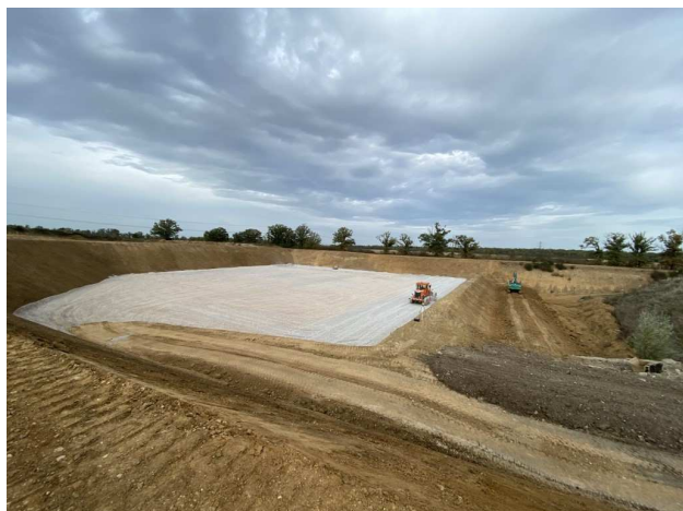
Casier D1 en cours d'achèvement (pose couche drainante)
