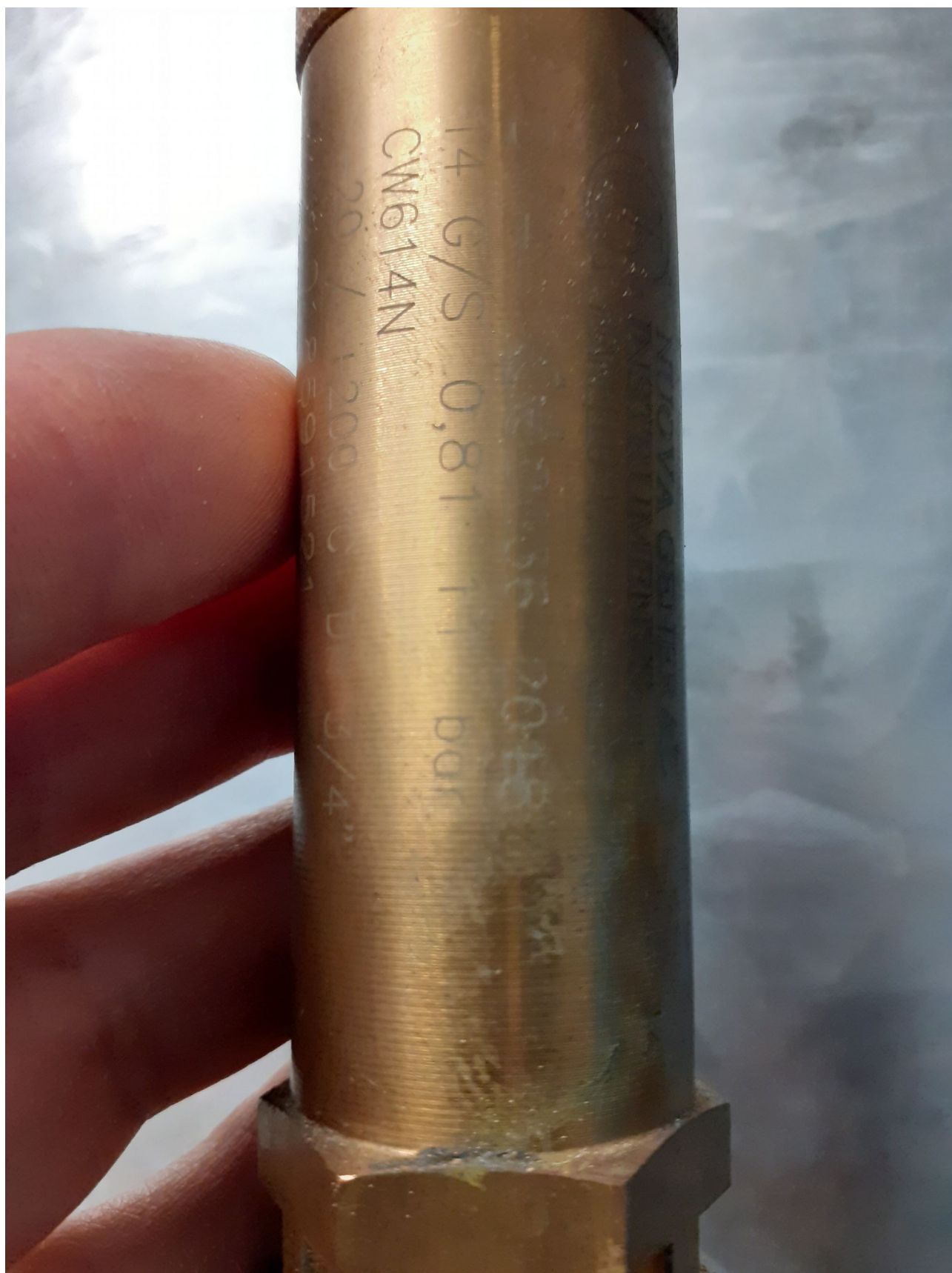
5 – soupape 11 b de la cuve CORDIVARI 900 litres
