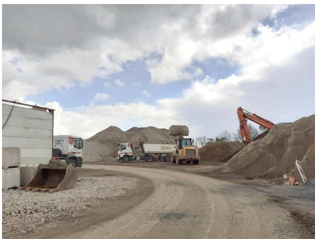
Photographie 2. Vue sur site lors du contrôle
