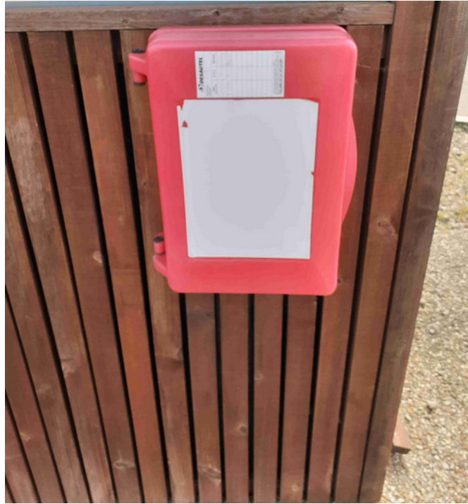
Coffret de la couverture anti-feu
