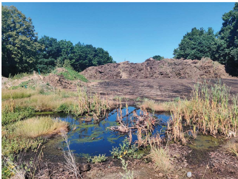
Plateforme de compostage
