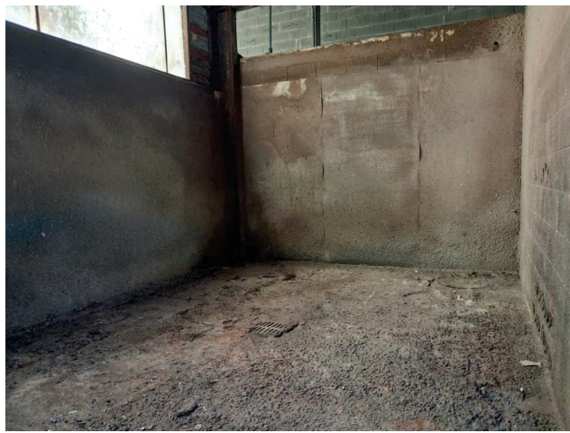
Zone de décapage
