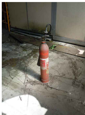
Présence d'un extincteur
