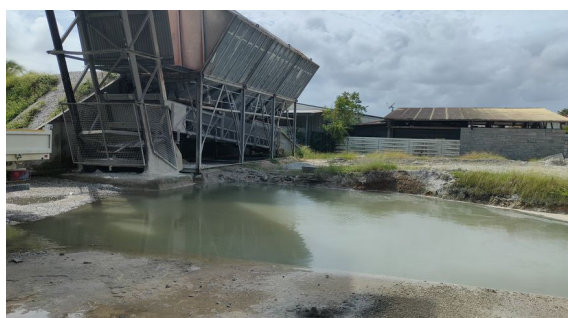
Premier bassin de décantation
