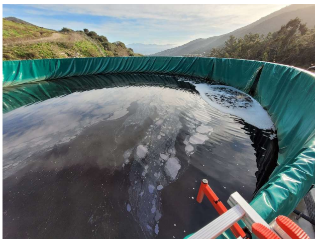
Vue du dessus du bassin de 1000m 3
