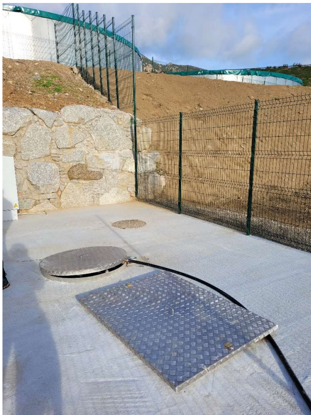
Poste de refoulement des lixiviats avant envoi dans les bassins
