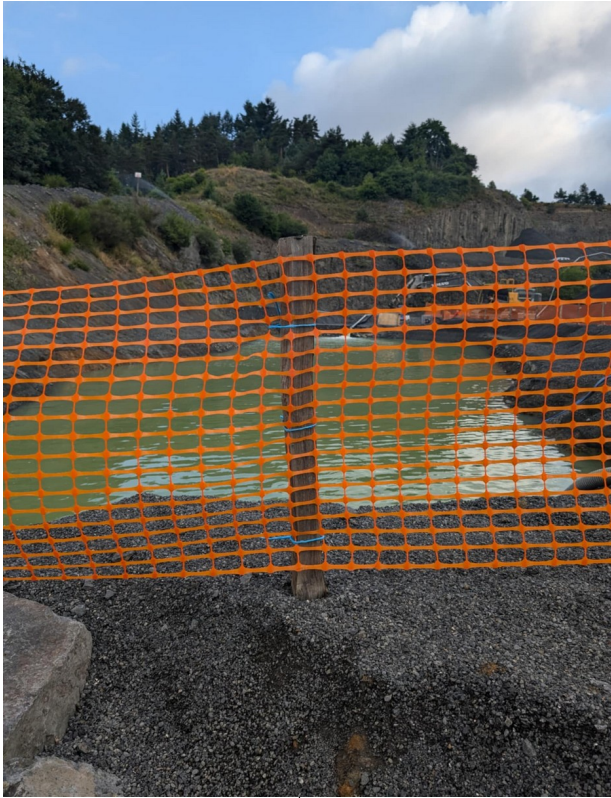
Premier bassin de décantation
