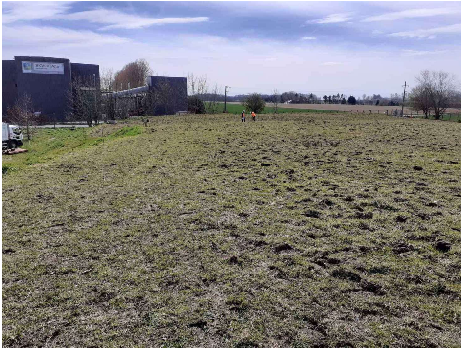
Illustration 1 : Investigations en cours au point T6, sur la couverture du casier 2
