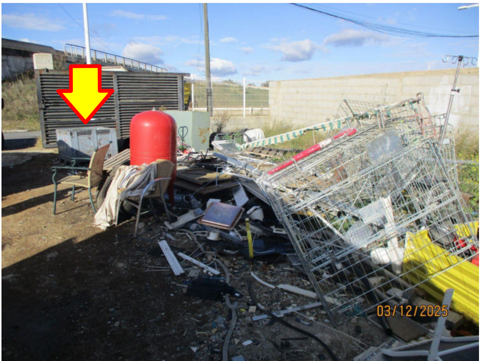
Déchet d'équipement électrique et électronique (ballon d'eau chaude rouge), déchets de métaux et bac en plastique contenant des batteries usagées au plomb (repérée par la flèche jaune)
