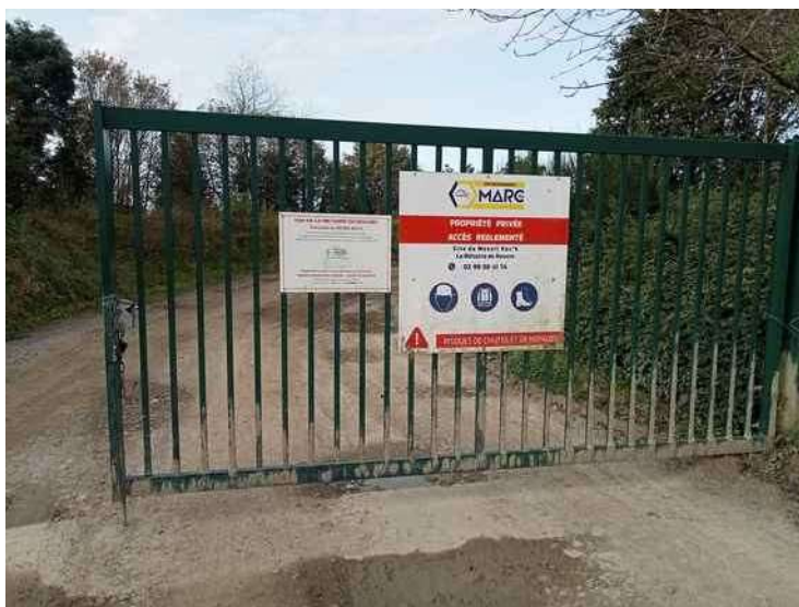
photo de l'inspection du 26 septembre 2023 : portail et panneau d'affichage
